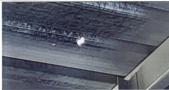
Foto1: Sustitución de lámina, por lámina troquelada aluzinc calibre 26 en módulos de aulas
