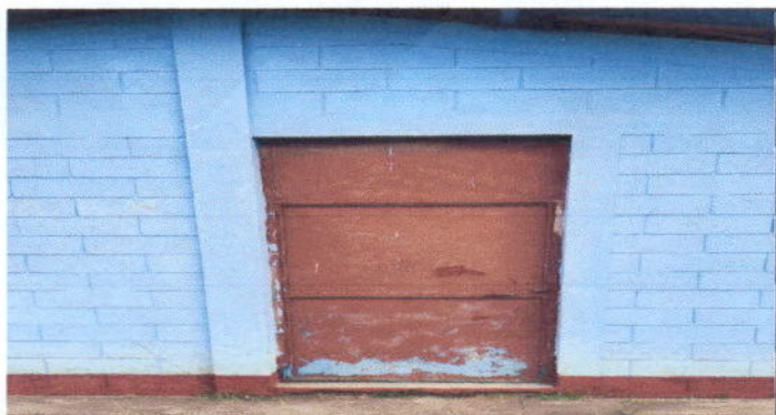
Foto 4: Fabricación e instalación de puertas de metal en módulo de aulas
