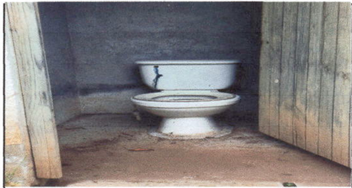
Foto 6: Sustitución de inodoro en módulo de baños
